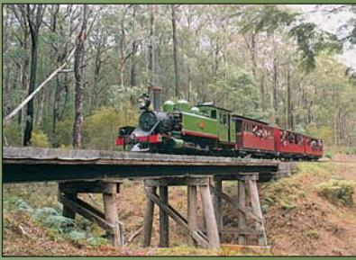
再往前就到了第三座桥，该座桥有10个直桥孔横跨考克吐(Cockatoo)河，长45.7米(150英尺)，高4.6米(15英尺)。考克吐河是全线从起点贝尔格雷佛站到终点雷克夏站之间最低的地方，这也是一段5.2公里(3.25英里)的大坡度爬升(1:30)开始的地方。火车经过这一段爬升后在抵达终点站简布鲁克前达到全线的最高点。
